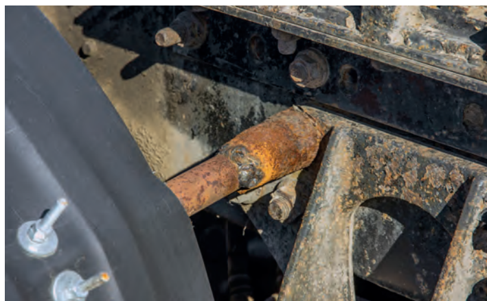
▲ Повышенная вибрация от дорог низкого качества способна разрушить ряд конструктивных элементов. Приваренные кронштейны «локеров» – яркое тому подтверждение
