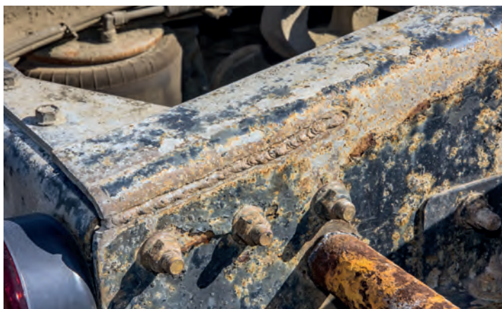
▲ Заваренные трещины в силовых элементах рамы говорят о том, что машина работала в сложных условиях. Внимательно проверьте техническое состояние её агрегатов
