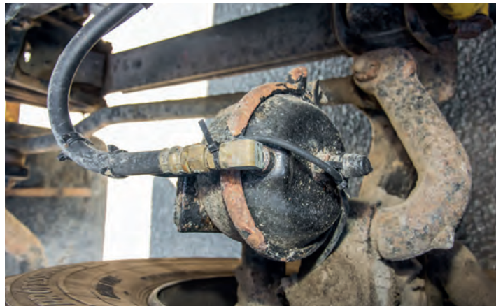
▲ Перед выпуском грузовика на линию важно проверить исправность тормозной системы и заменить все изношенные детали или неисправные агрегаты
