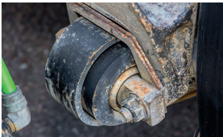
▲ При проведении технического обслуживания важно не забывать про протяжку элементов подвески
