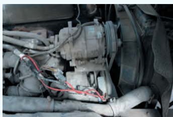
▲ Компрессор холодильной установки
