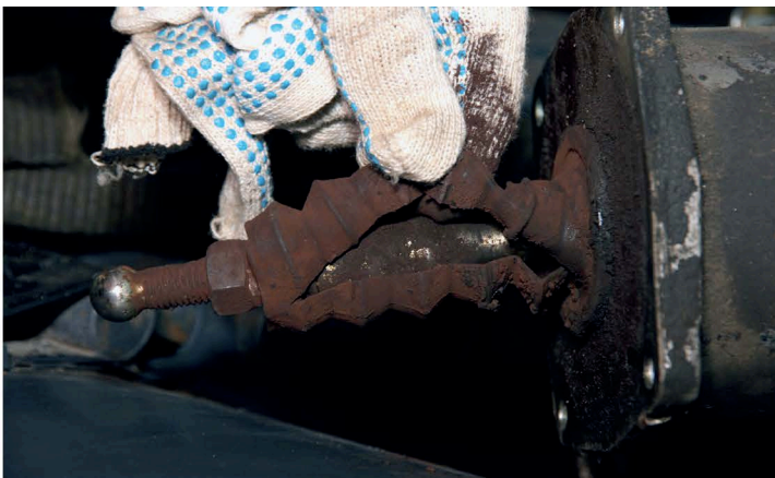
▲ Если в процессе эксплуатации грузовика наблюдаются сбои в работе сцепления, необходимо в обязательном порядке проверить исправность ПГУ. У представленного на фото агрегата был порван чехол штока
