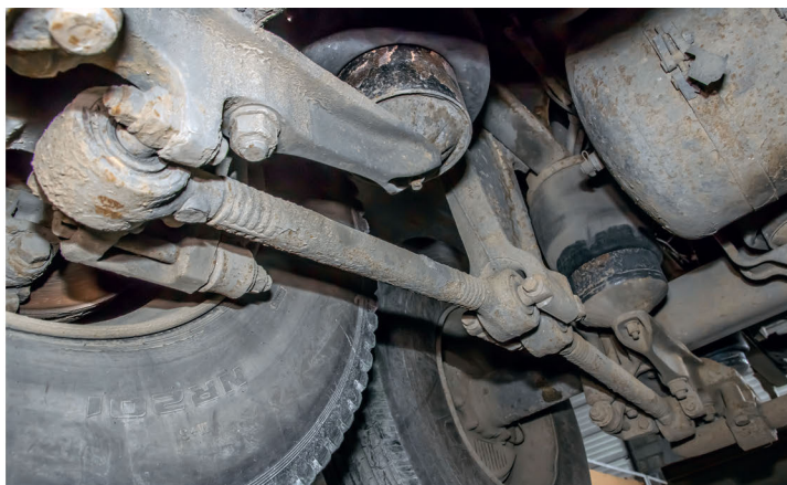
▲ Тяги и штанги способны пройти 700 000 и более километров. Скорее всего, на вашем грузовике их уже заменили. Ремонтить тяги перепрессовкой резино-металлических шарниров – пустая трата времени и сил
